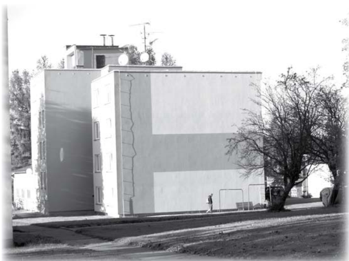
Kompletní zateplení bytového domu v Dolních Kralovicích.
